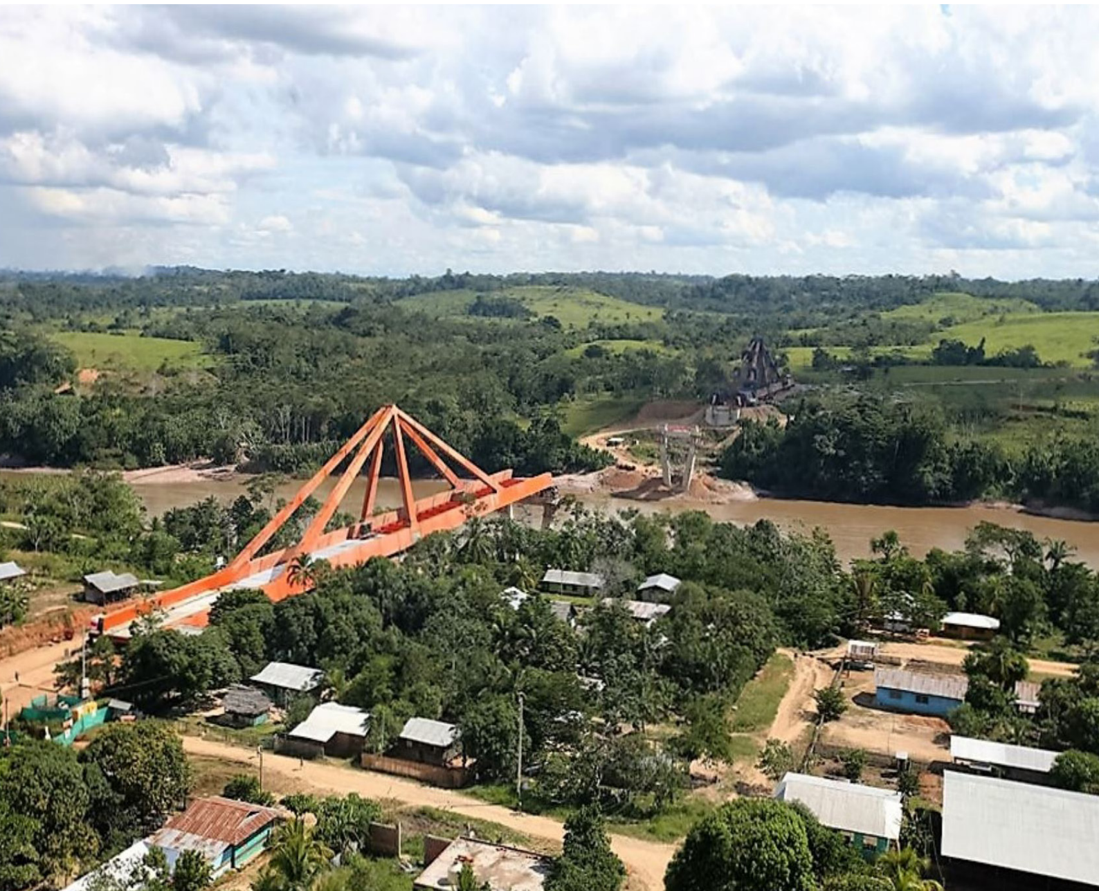
El puente Pachitea beneficia a más de 20,000 pobladores de la provincia de Puerto Inca, región Huánuco.
