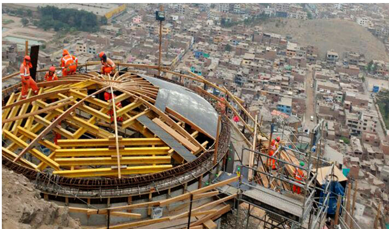
Proyecto de agua potable y alcantarillado en el distrito de Independencia.
