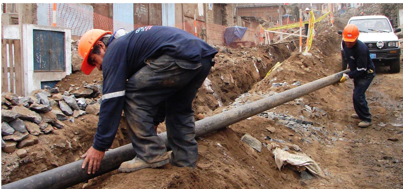
Ejecución de obras de saneamiento en San Juan de Miraflores.
